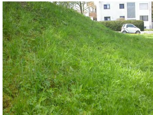
Bild 10: Südlicher Böschungsbereich. Große Teile der Böschung sind mit Gras bewachsen
