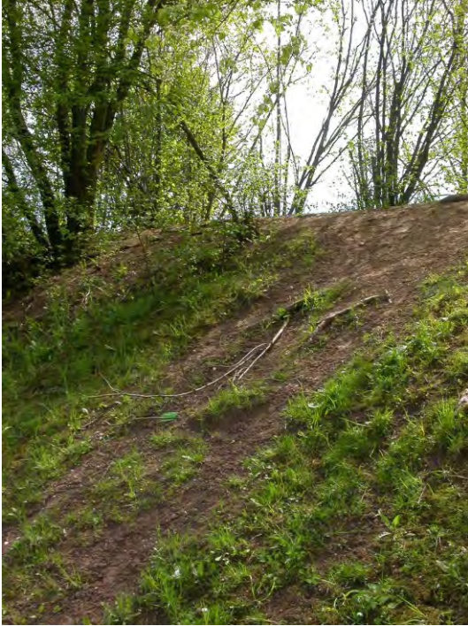
Bild 13: Gestörter Böschungsbereich im Süden des UR mit Trittpfaden, entstanden bspw. durch spielende Kinder
